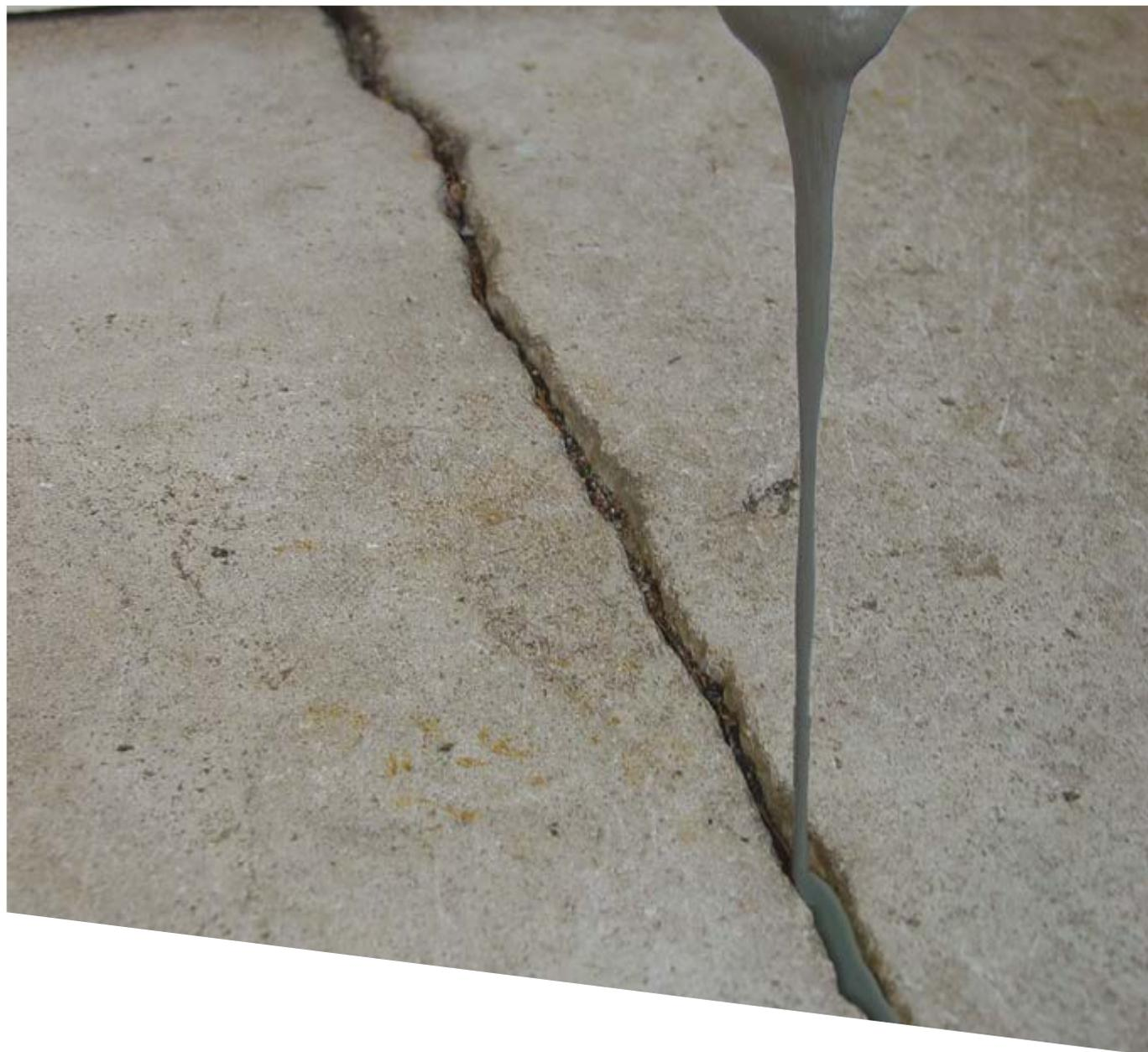
Les fissures sont fréquentes sur les sols en béton. Elles sont généralement provoquées par des dépôts, des mouvements structurels dans le cas de constructions plus anciennes, un trafic intense, ou la chute d'objets.
