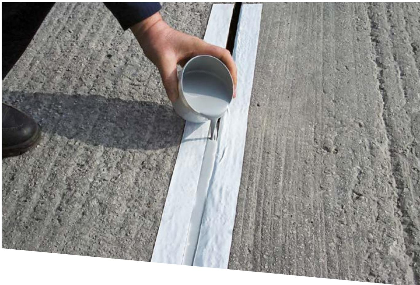
Les joints de dilatation ou pour bords de quais sont une part intégrante des sols en béton. Les premiers empêchent le matériau de se fissurer lorsqu'il se dilate ou se contracte sous l'effet des variations de températures, tandis que les seconds se créent lorsque le béton est versé sur plusieurs jours.
