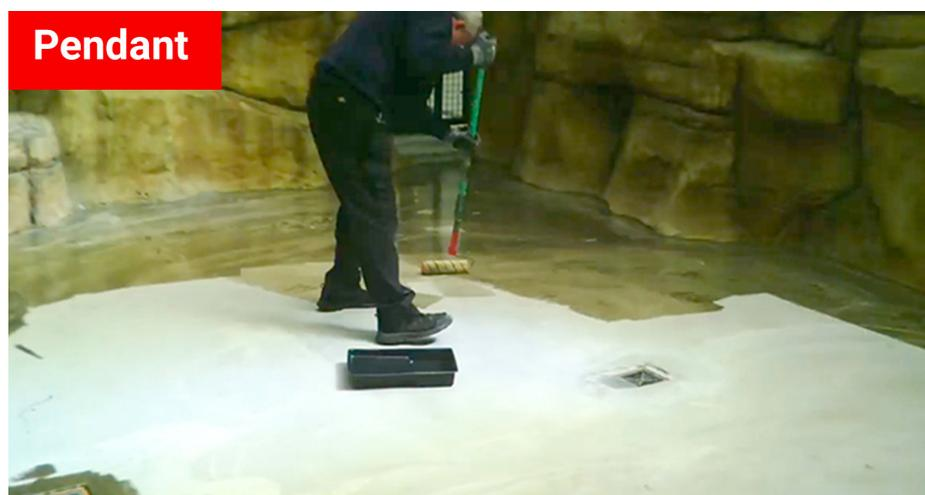
**“La peinture est extrêmement tolérante aux produits chimiques et suffisamment résistante pour supporter 95 % d'acide sulfurique. Une peinture de sol ordinaire ne résisterait pas à l'usure.”**
