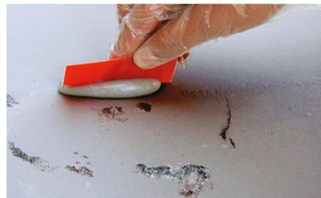
Concrex<sup>®</sup> Retouche Kit est une pâte bicomposante à base de résine époxy destinée à combler les brèches, fissures et petits trous dans le béton et la maçonnerie.
